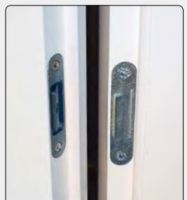
Bandseitensicherung
