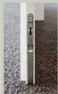
Bodenverriegelung des Standflügels
