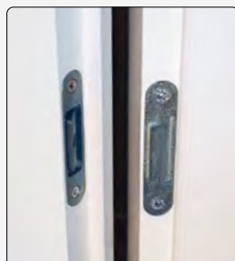
Bandseitensicherung
